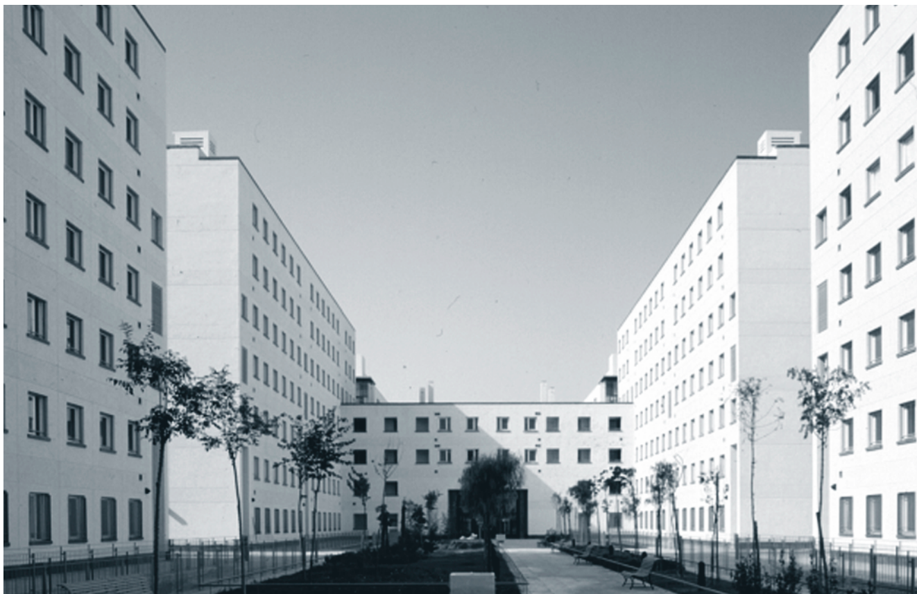
(fig. 4) Empresa Municipal de Vivienda, Suelo y Equipamiento de Sevilla S.A. EMVISESA, "Manzana D del SUT-SUR Pino Montano", 246 viviendas, locales comerciales, garajes y trasteros, 1995. Arquitectos: Miguel Díaz Zulategui y Enrique Abascal García.
