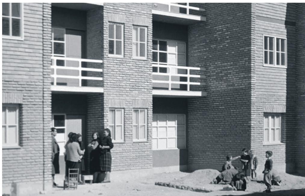
Miguel Fisac. Viviendas experimentales en Villaverde, 1954.
