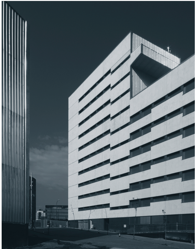
21/22 Empresa Municipal de la Vivienda y Suelo de Madrid S.A. EMVS, "Sanchinarro 12", 176 Viviendas VPP-SPT en Hortaleza, Madrid, 2006. Arquitectos: Francisco Burgos y Ginés Garrido. fotógrafos: Elena Almagro y Roland Halbe.
