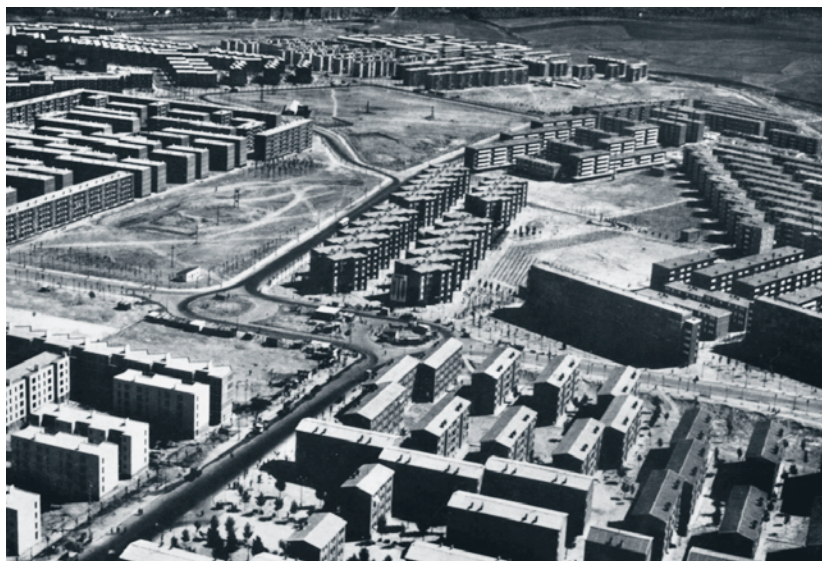
Imagen aérea del Gran San Blas en construcción, Madrid, 1958-1962.
