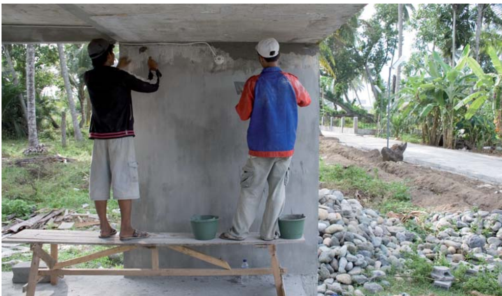
Fase de acabados.
