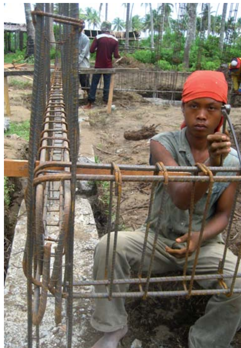
Viga de cimentación.
