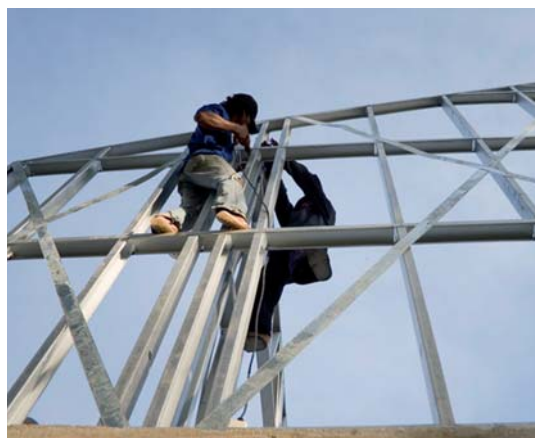
Estructura 1ª planta.
