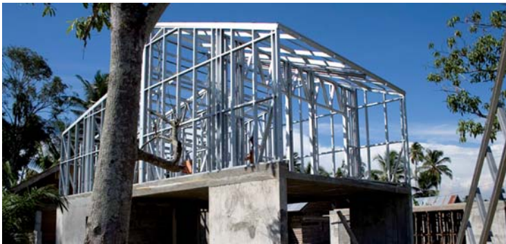
Planta primera finalizada.
