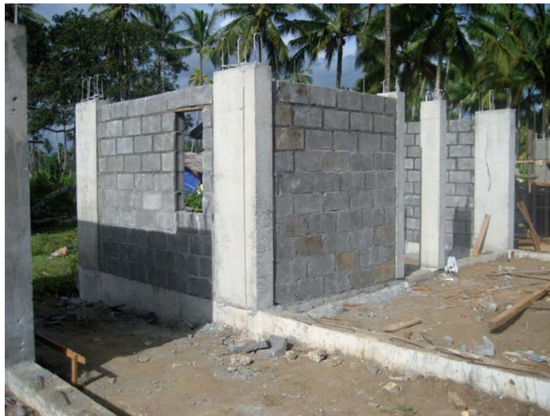
Muros de bloques de hormigón.
