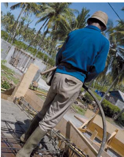
Hormigonado forjado.
