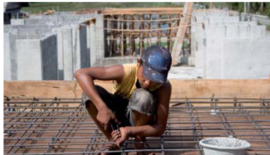
Armadura forjados.
