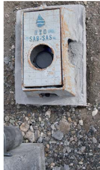
Instalación contador electricidad y agua.
